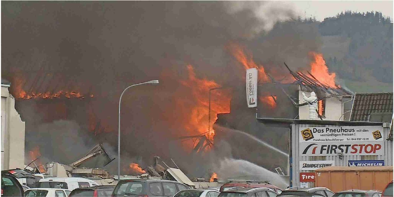
Zahlreiche Gewerbebetriebe fielen dem Feuer im Hinwiler Industriegebäude zum Opfer. Was den Brand ausgelöst hat, wird noch untersucht. Foto: BRK News
