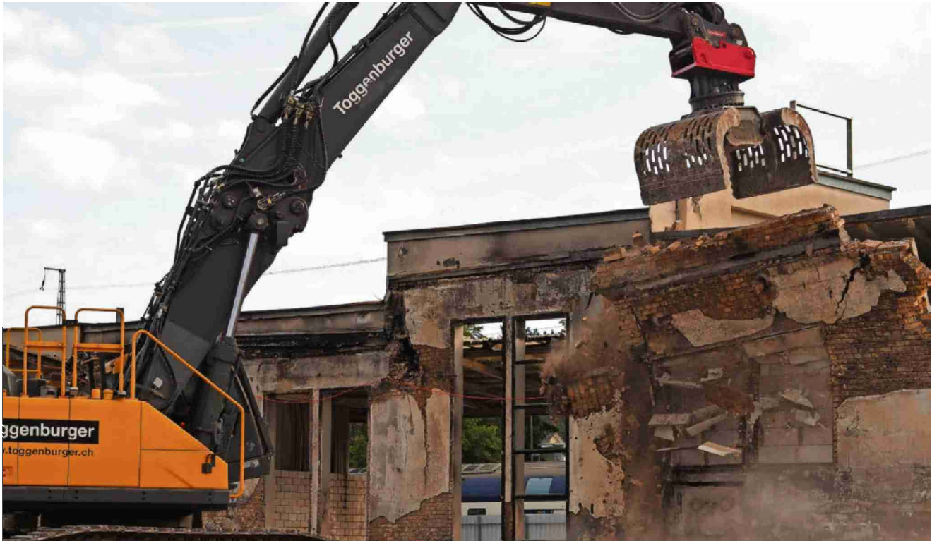
Ein Abrissbagger verrichtet auf dem Gelände der geschichtsträchtigen Bührer Traktorenfabrik AG sein Werk. Foto: Erik Hasselberg
