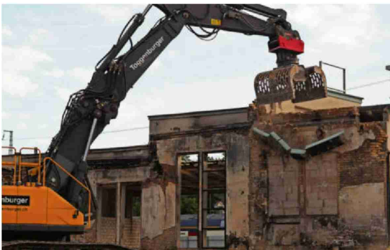
Ein Abbruchbagger verrichtet auf dem Gelände der Bühler Traktorenfabrik AG sein Werk. Foto: Erik Hasselberg
